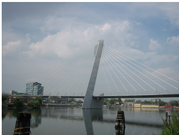
Il ponte strallato di PortoMarghera (Venezia) per l'accesso all'isola portuale
